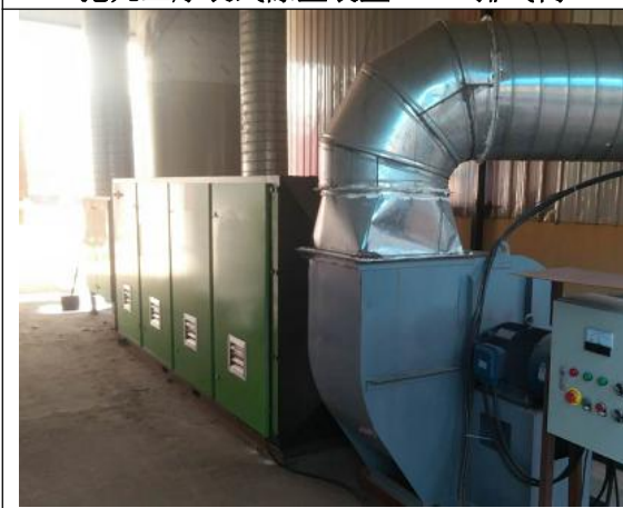
抛丸工序袋式除尘装置+15m 排气筒
