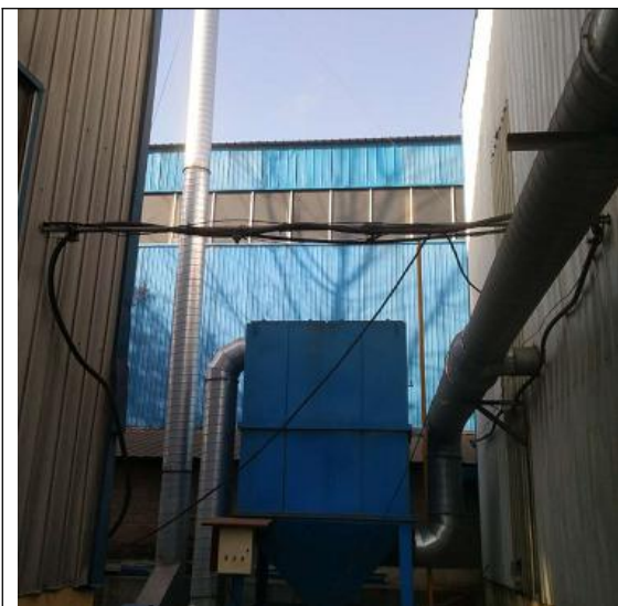
抛丸工序袋式除尘装置+15m 排气筒
