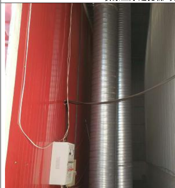
烘干工序光催化装置+15m 排气筒
